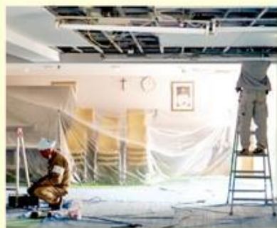
会館6階 空調工事
